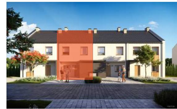
Widok od frontu budynku
