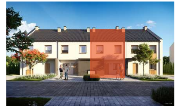
Widok od frontu budynku
